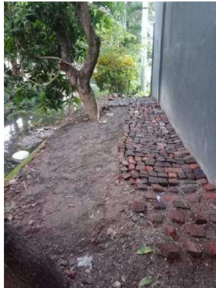
Gambar 2. Lahan yang telah selesai dibersihkan.
