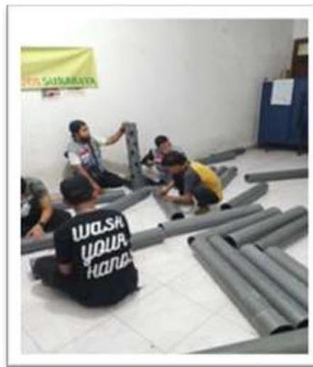
Gambar 2. Proses Pemotongan Pipa Paralon
