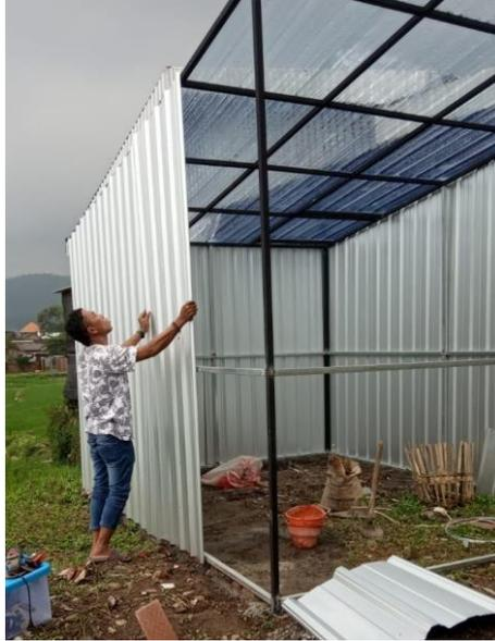
*Gambar 8. Pemasangan Dinding Sepandek*
