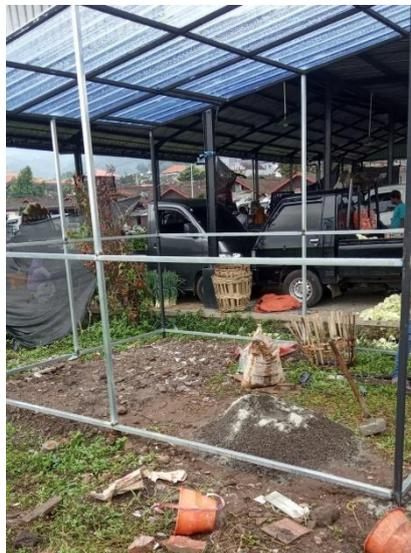
*Gambar 7. Konstruksi Rangka Batang dan Rangka Atap Terpasang*
