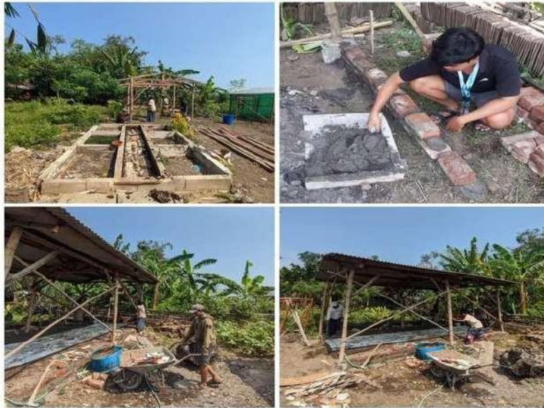
Gambar 8. Pembangunan Rumah Maggot
