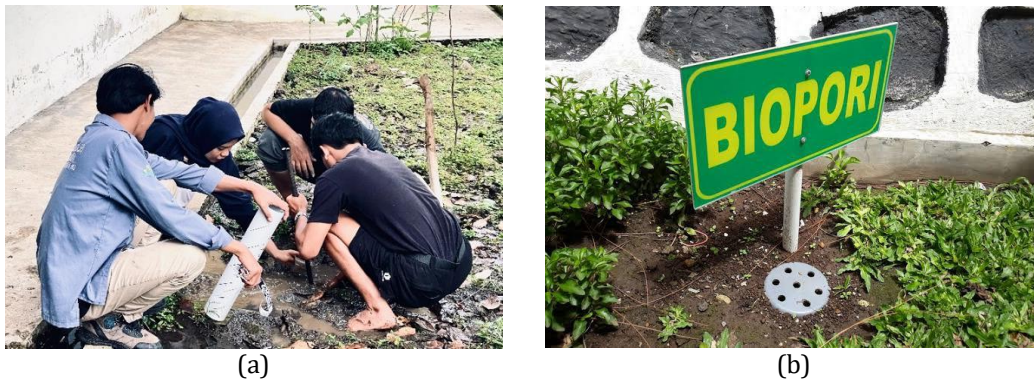
Gambar 2. Pelaksanaan kegiatan: (a) Proses pembuatan lubang biopori di Gg. Saburai, Bandar Lampung; (b) Lubang Biopori yang telah selesai dibuat.
