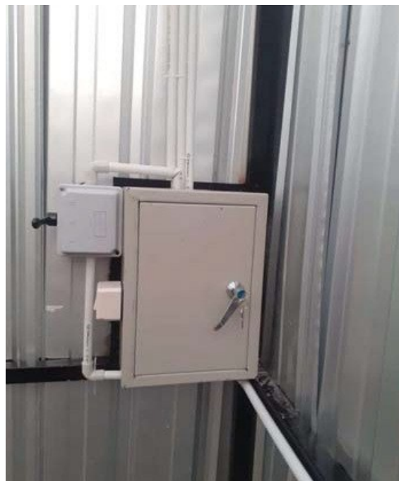
Gambar 8. Pemasangan Box Panel, Saklat dan OHM Switch
