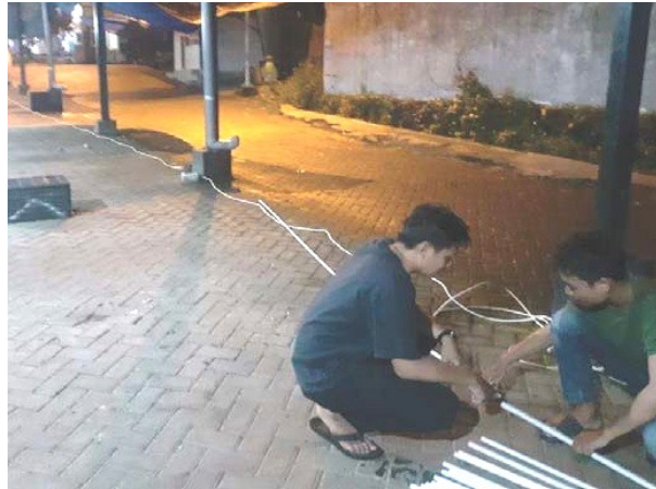
Gambar 5. Proses Fabrikasi Bahan-bahan Instalasi Listrik.
