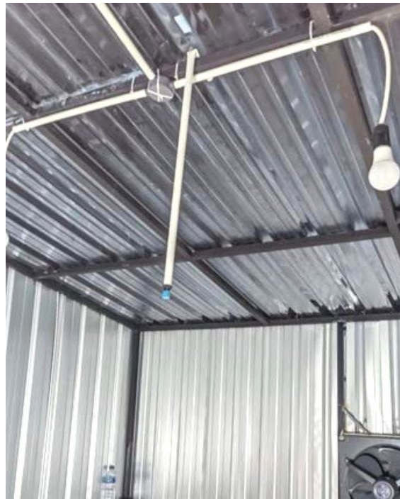
Gambar 7. Pemasangan Kabel dan Lampu Penerangan
