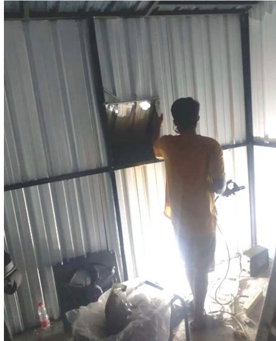
Gambar 6. Pemasangan Exhaust Fan
