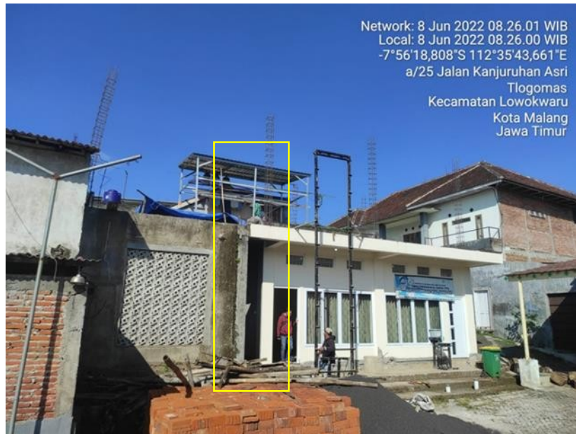
Gambar 5. Tahapan Persiapan Pembangunan Gedung TPQ
