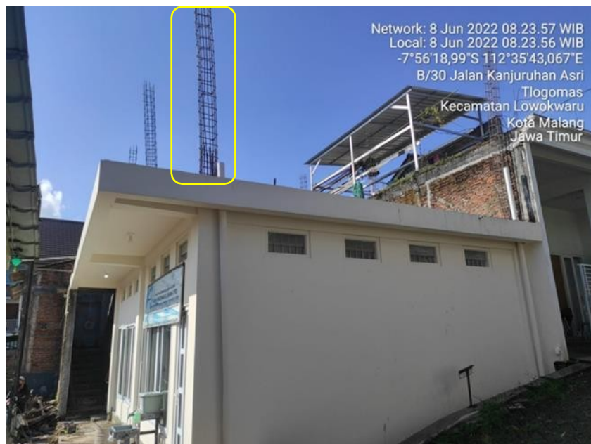
Gambar 6. Tahapan Pembangunan Kolom Gedung TPQ
