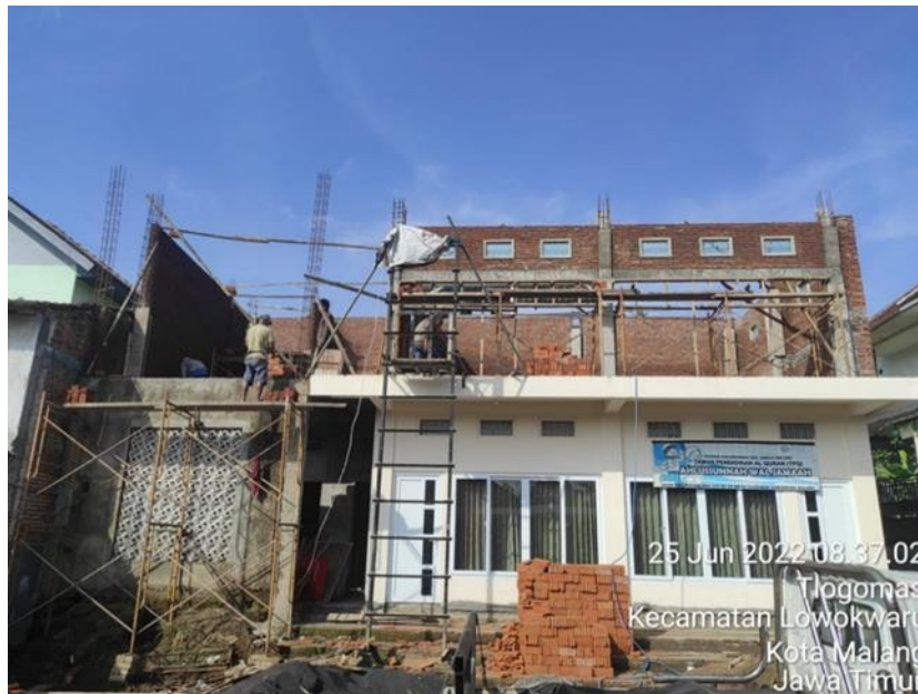
Gambar 8. Tahapan Pembangunan Dinding sisi Selatan Gedung TPQ
