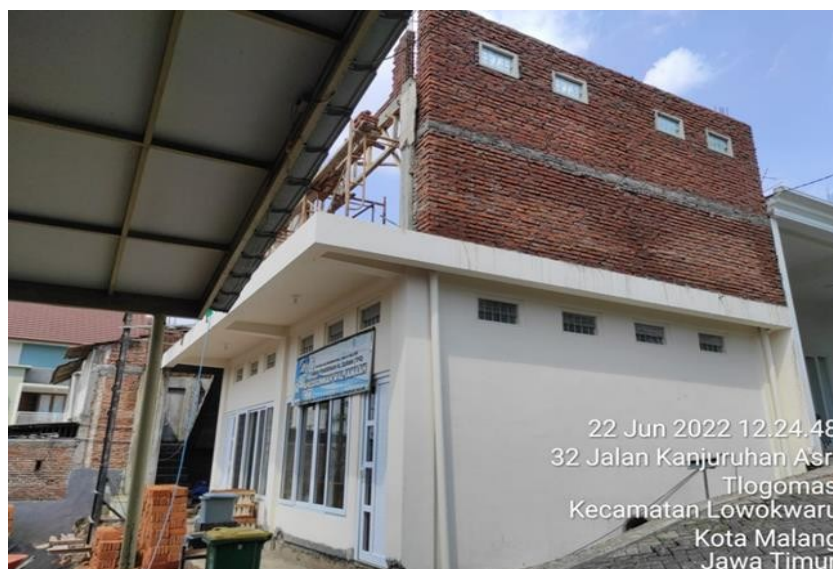
Gambar 7. Tahapan Pembangunan Dinding sisi Barat Gedung TPQ
