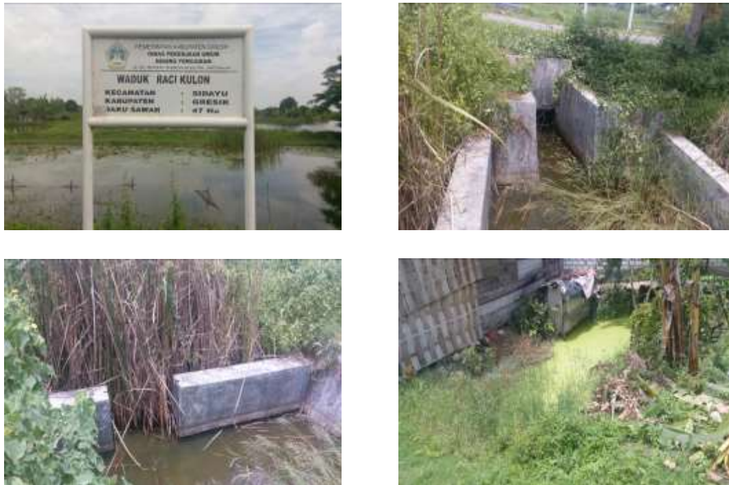
Gambar 2 : Kondisi Eksisting D.I. Raci Kulon
