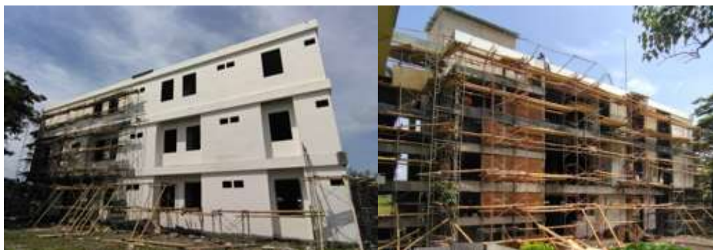
Gambar 15. Hasil Pekerjaan Bulan Nopember 2023.
