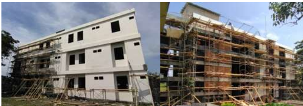
Gambar 15. Hasil Pekerjaan Bulan Nopember 2023.
