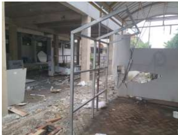
Gambar 6. Rangka batang terpasang
