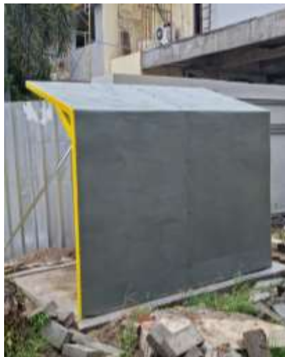
Gambar 7. Pemasangan dinding dari plat besi
