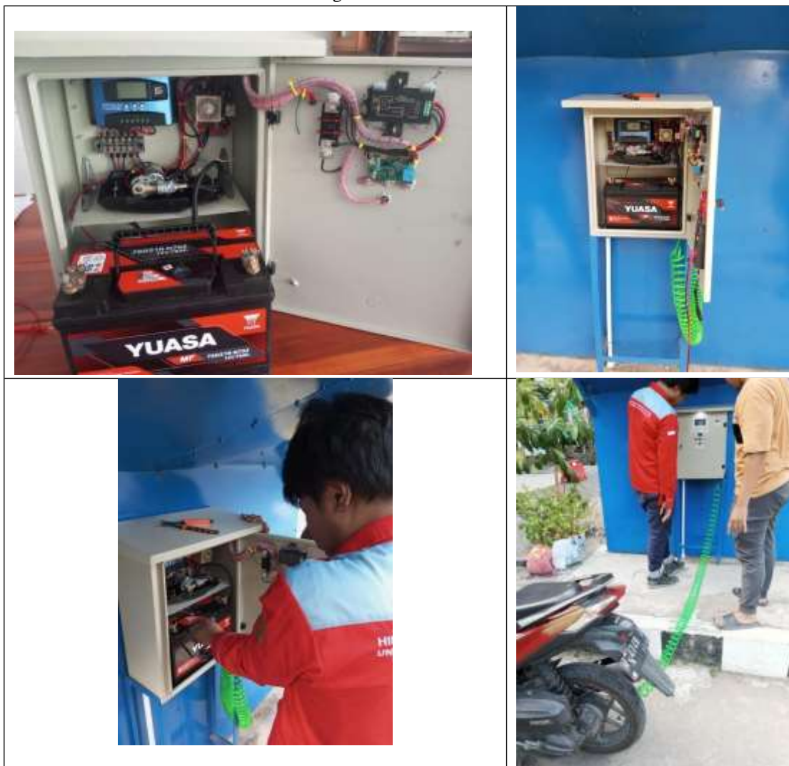
Gambar 5 Pemasangan Perangkat Pompa Angin
