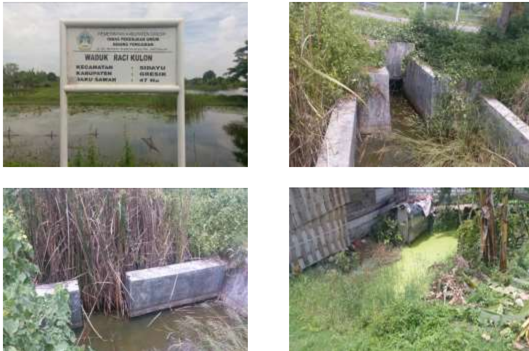
Gambar 2 : Kondisi Eksisting D.I. Raci Kulon
